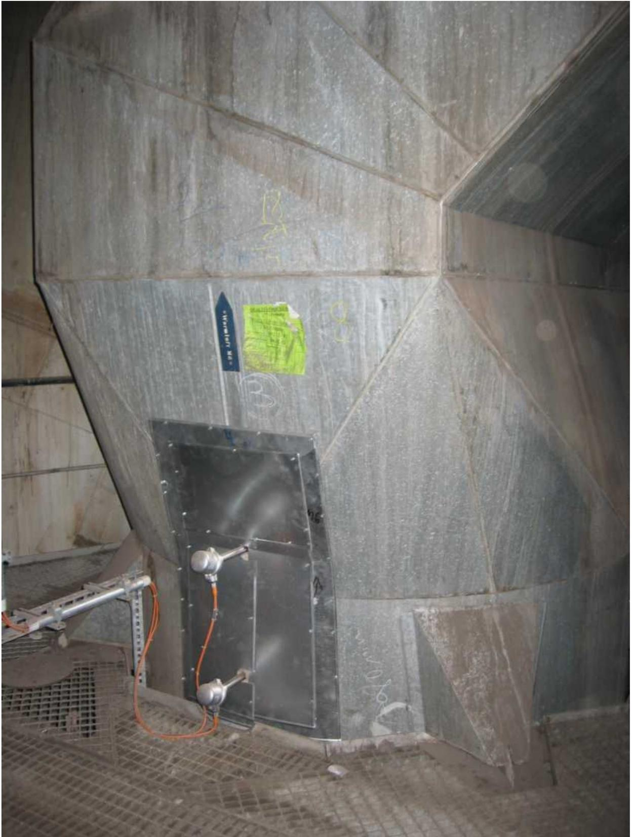
照片2 传感器在一个测量位置的典型安装方法
